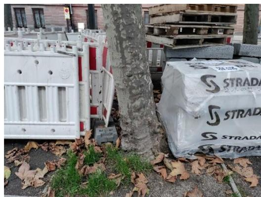
Photo 7 : Stockage de matériel de chantier au pied de l'arbre = asphyxie du système racinaire + risques de chocs au tronc
