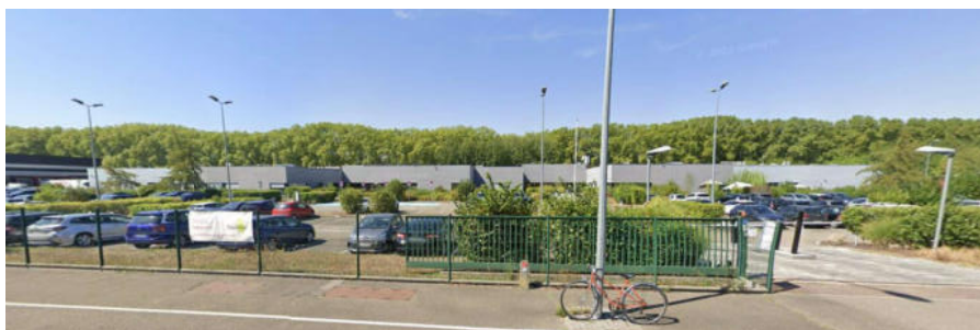
Immeuble ALSACIA 6 rue Eugène Brazier 67 400 ILLKIRCH
