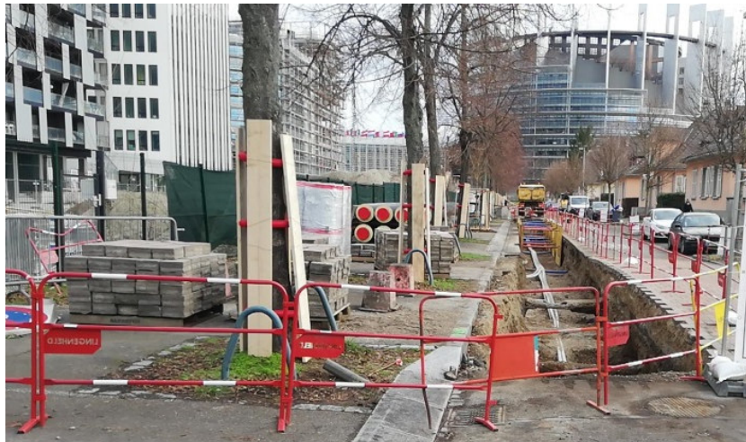
R-CUA – Pose d'un réseau de chaleur à Strasbourg
