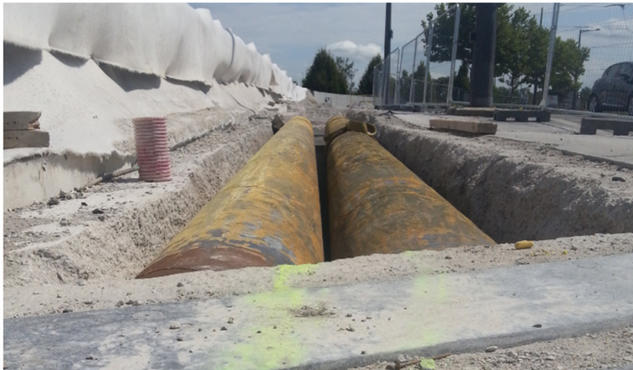
Travaux similaires réalisés sur le réseau du Wacken
