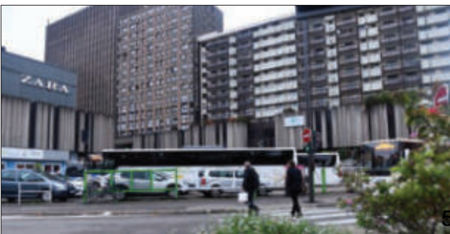
La gare routière laissera place, d'ici 2025, à une « gare passante ».
