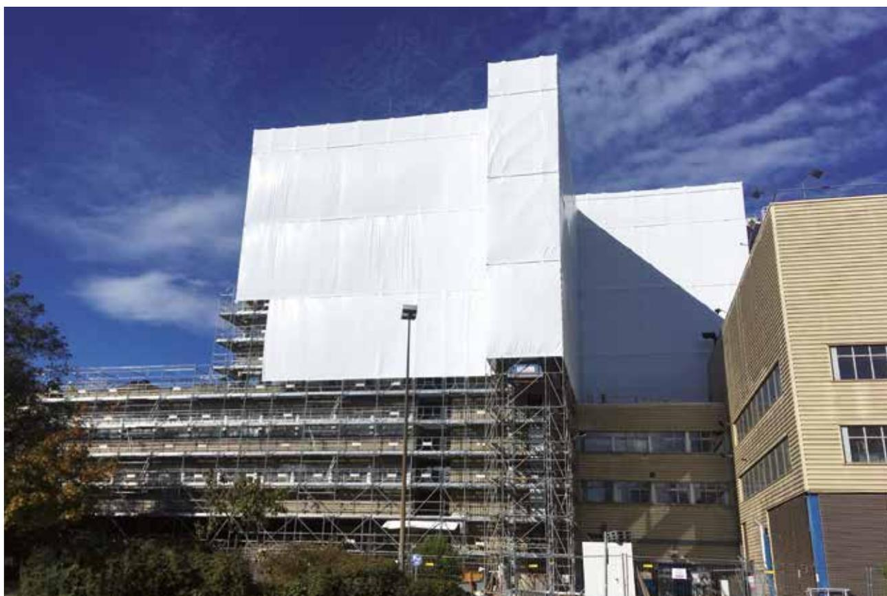
Confinements mis en œuvre pour le retrait des façades dans le cadre de la phase 2 des travaux de désamiantage.
