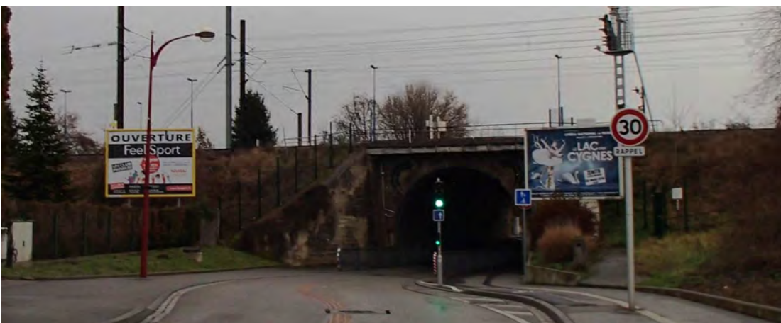
Vue 4 - emprise ferroviaire Mundolsheim vers la D 263
