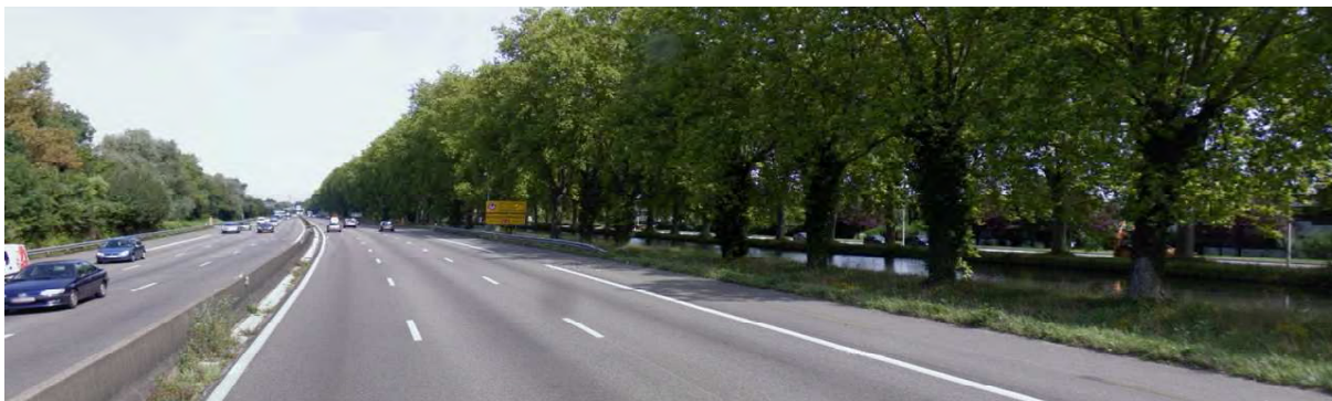
Vue 1 -ZPR 4 Strasbourg canal à l'est rue de l'Unterelsau à l'ouest
