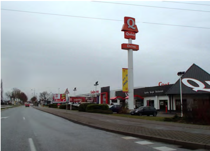
Vue 7 : Enseigne illégale scellée au sol dépassant la hauteur maximum prévue par le RNP (6,50 m)
