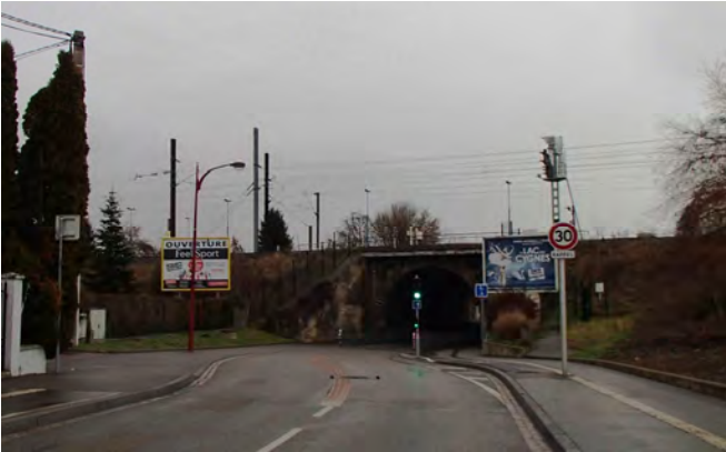
Mundolsheim : des publicités d'une plus petite surface et plus basses ne dépasseraient pas la ligne du talus
