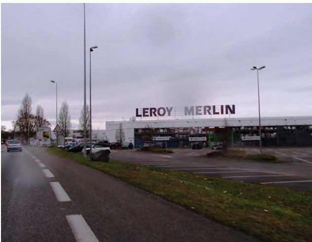
Ci-dessus, enseignes en toitures illégales (structures visibles, lettres non découpées)
