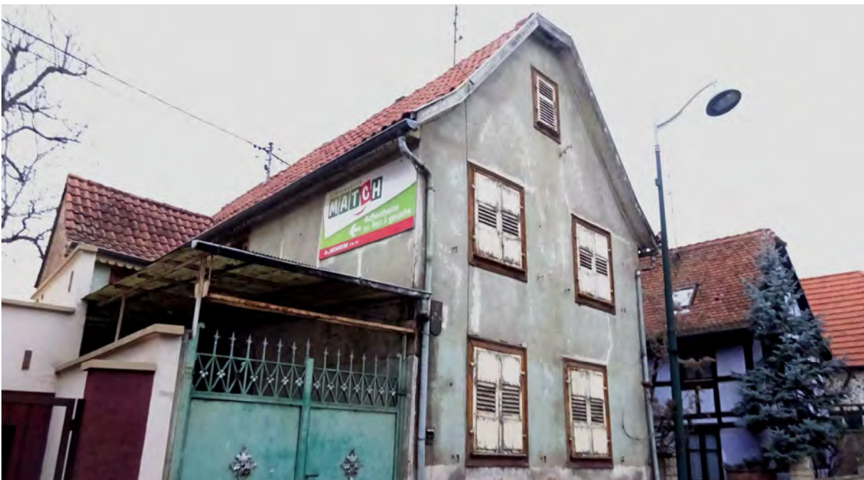
Wolfisheim : publicité illégale (mur non aveugle, une baie existe au-dessus de l'auvent, à gauche)
