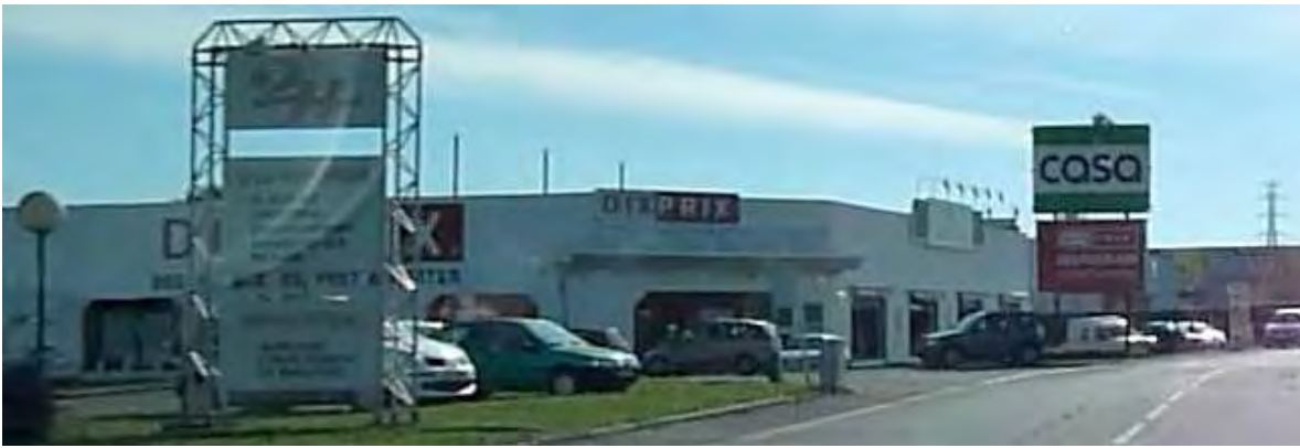
Vue 4- enseignes illégales dépassant la hauteur maximale admise (6,50 m)
