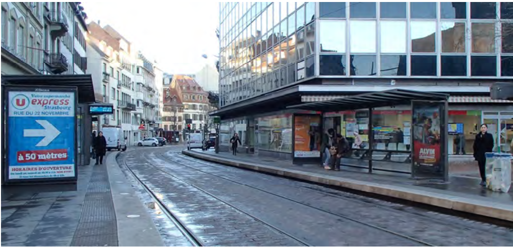
Deux abris destinés au public
