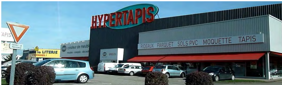
Vue 5- Enseigne illégale car dépassant du mur support
