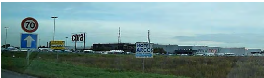
Vue 14 - Mundolsheim extrémité de la zone commerciale nord hors agglomération.
