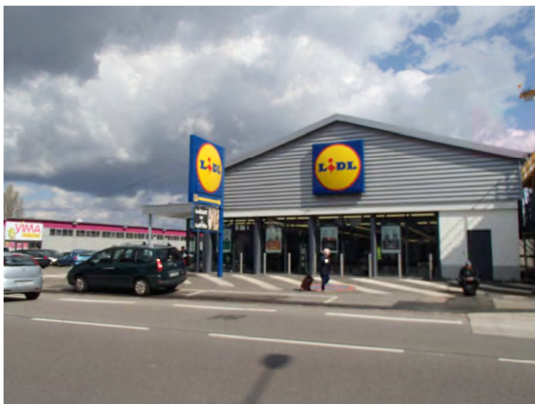
Une enseigne scellée au sol (à gauche), une enseigne murale (à droite)
