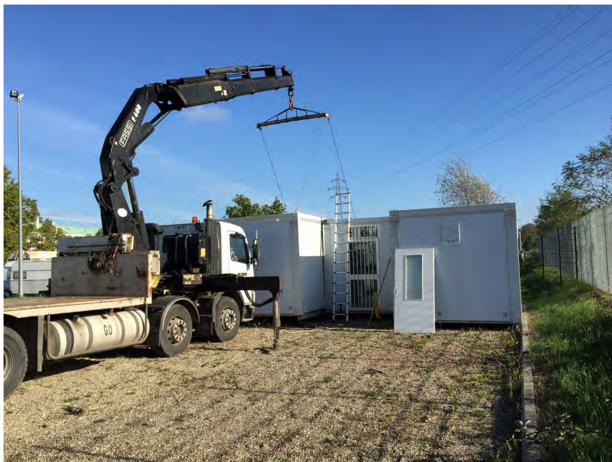
Installation du bâtiment modulaire sur l'aire de Strasbourg, rue de Dunkerque
