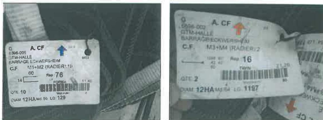
**Photo 11 : Etiquetage des ferrillages (Exemples de quelques uns des aciers en dépôt)**
