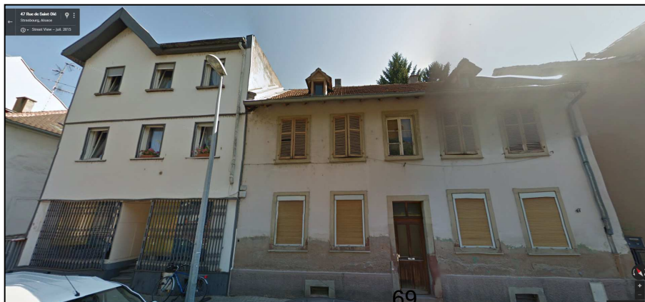
Immeubles 45 et 47 rue de Saint Dié
