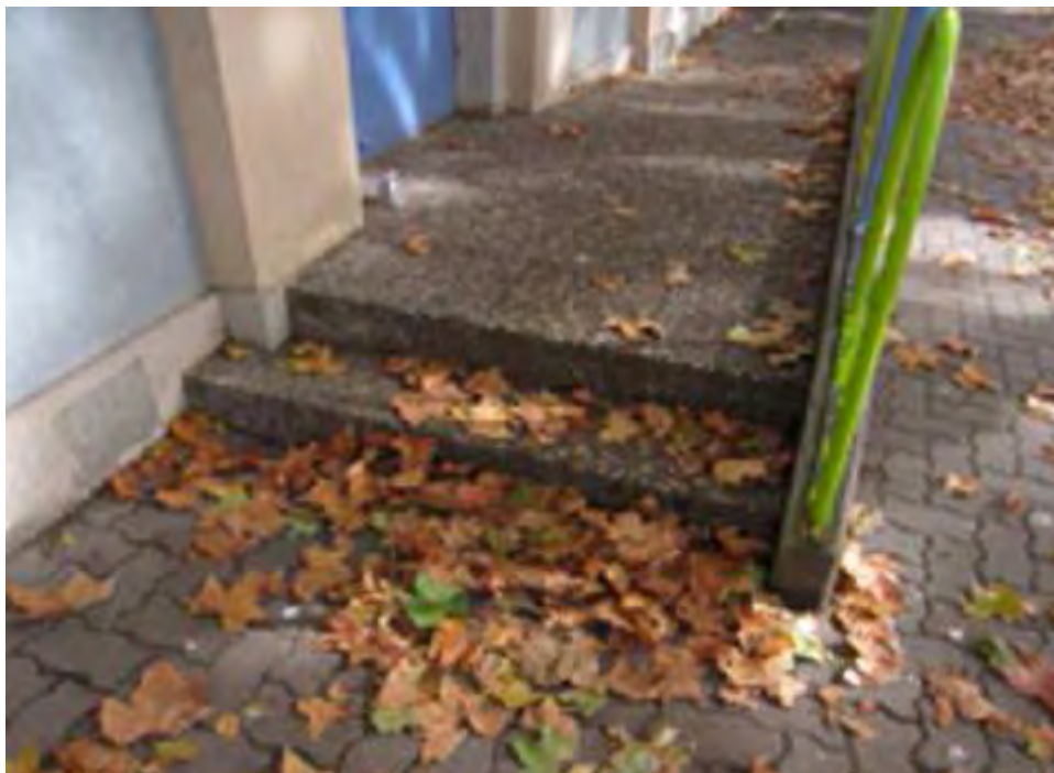
Remplacer les marches d'accès par des rampes
