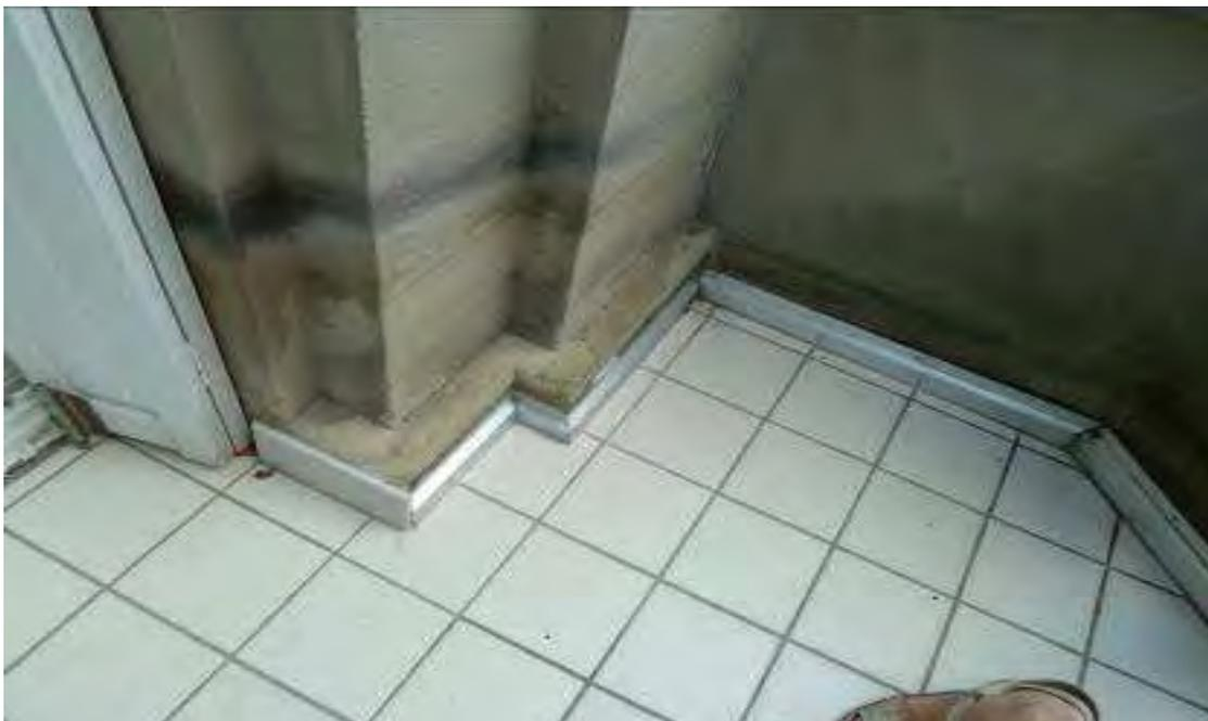
**Dalle de balcon carrelée – remontées capillaires**
