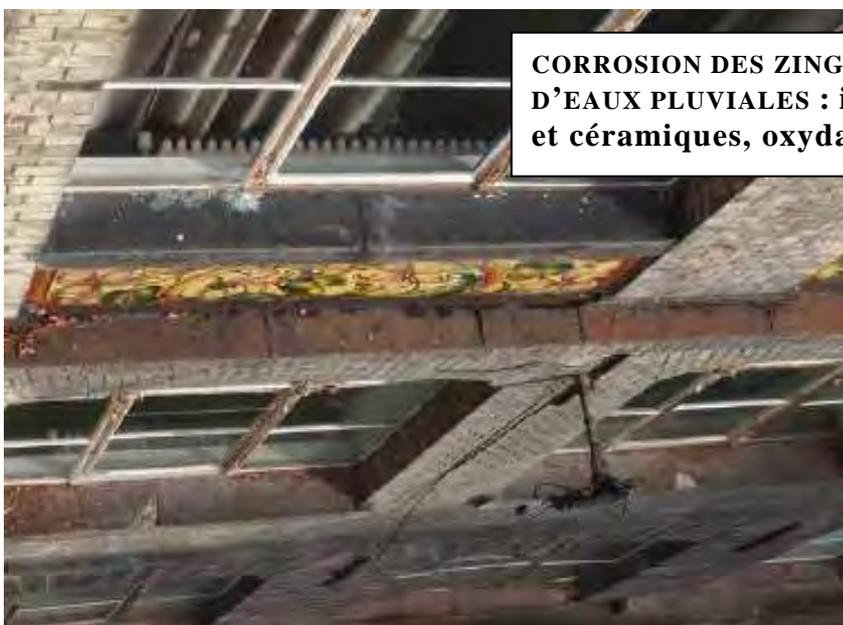
**CORROSION DES ZINGUERIES ET DESCENTES D'EAUX PLUVIALES** : imprégnation des briques et céramiques, oxydations noirâtres, sels...
