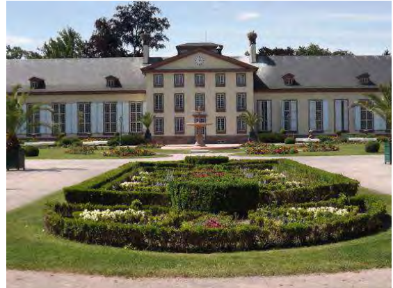
13. Pavillon Joséphine, parc de l'Orangerie
