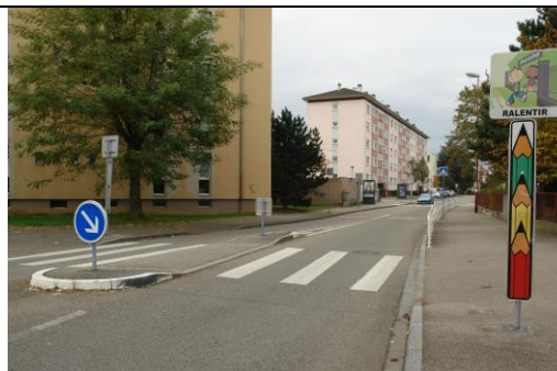
N°74 : photo de la rue de la Zorn, prise de vue depuis la rue de la Moder vers la rue de Bischheim
