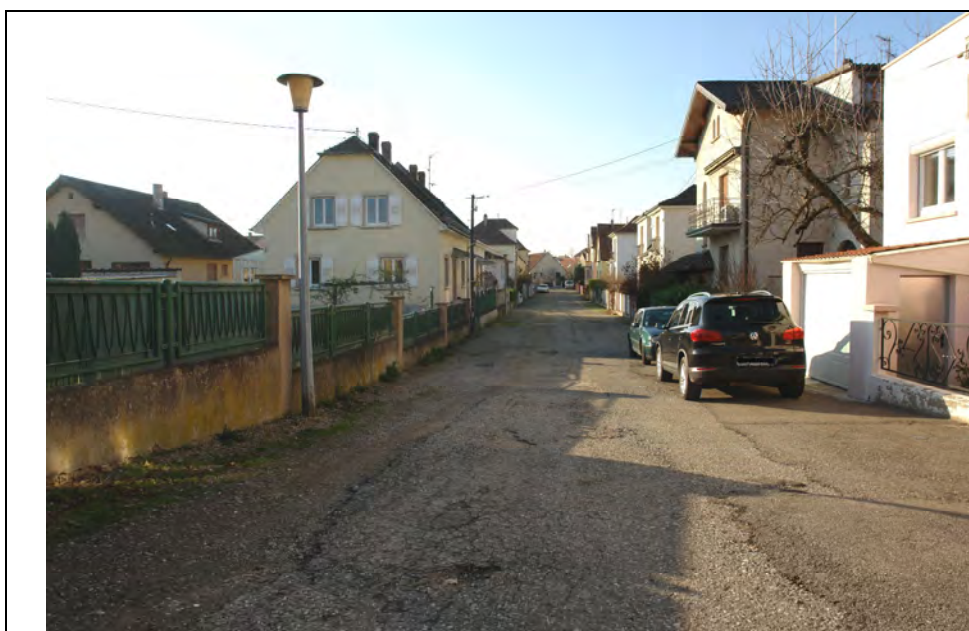
N°1 : Photo de la rue des Cigognes, prise depuis la rue d'Oberhausbergen
